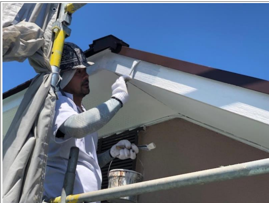
破風板 上塗り
