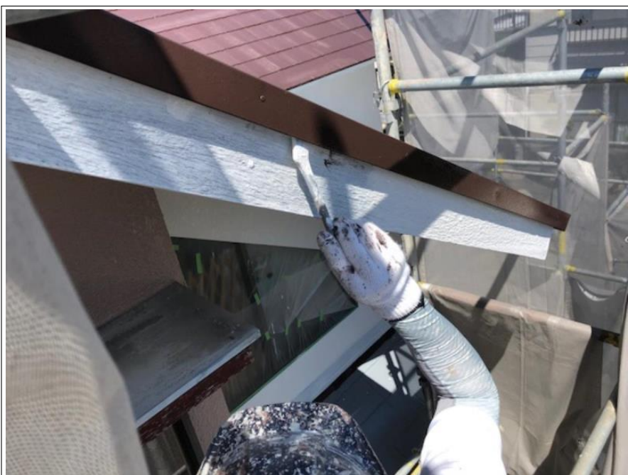
破風板 中塗り
