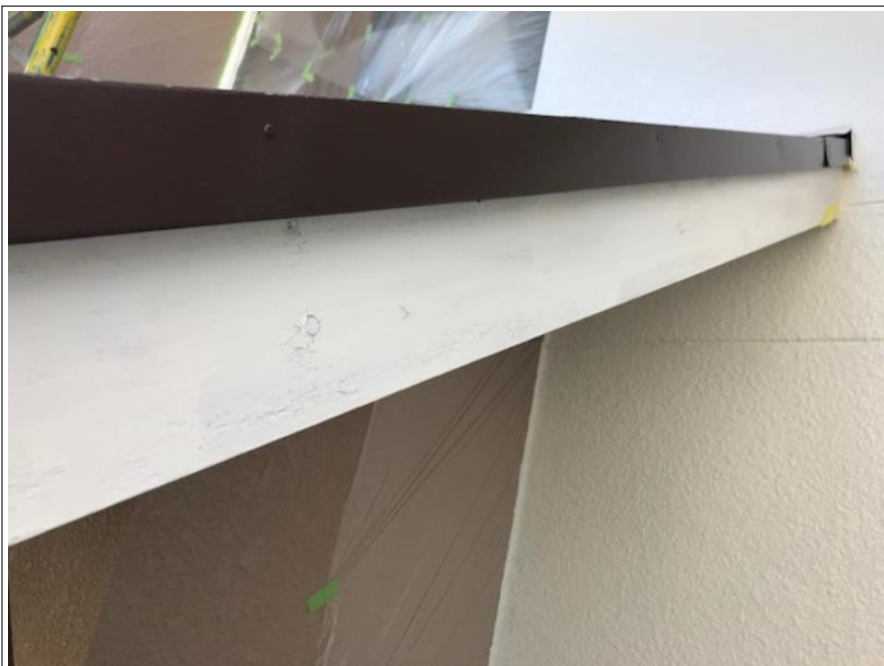
破風板 下塗り
