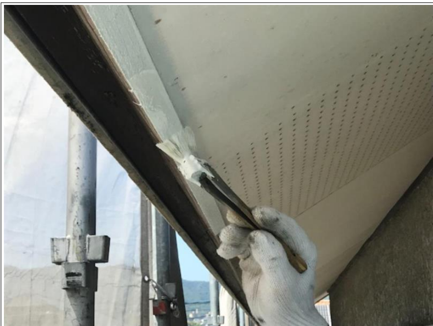
破風板 下塗り
