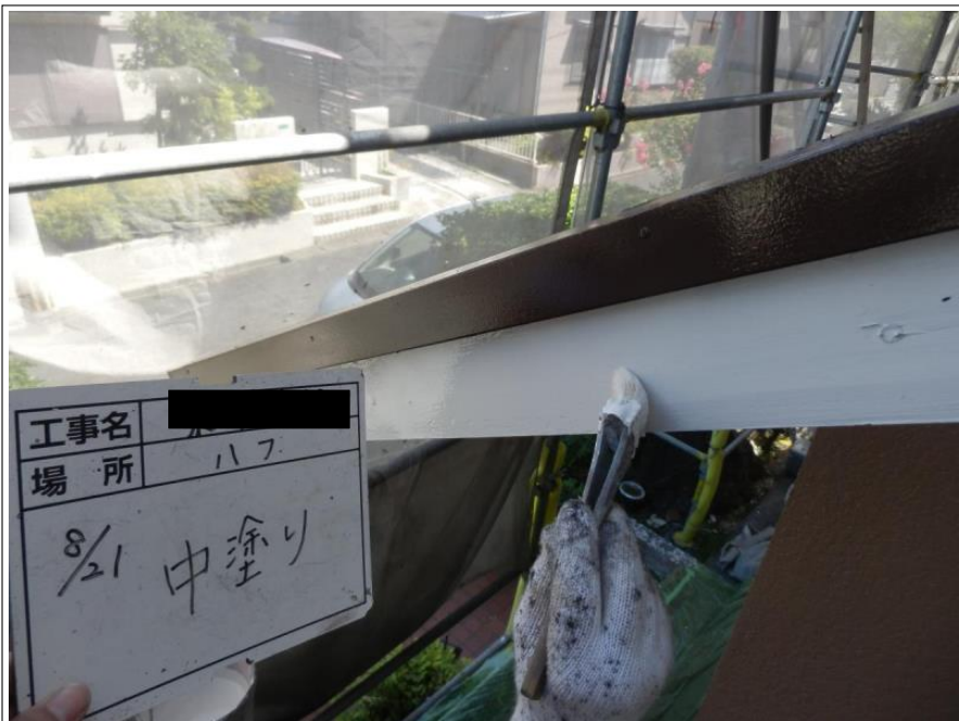
破風板 中塗り
