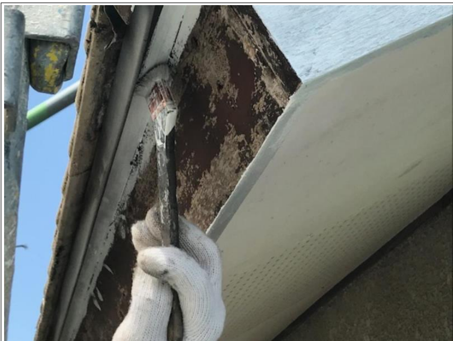
破風板 下塗り
