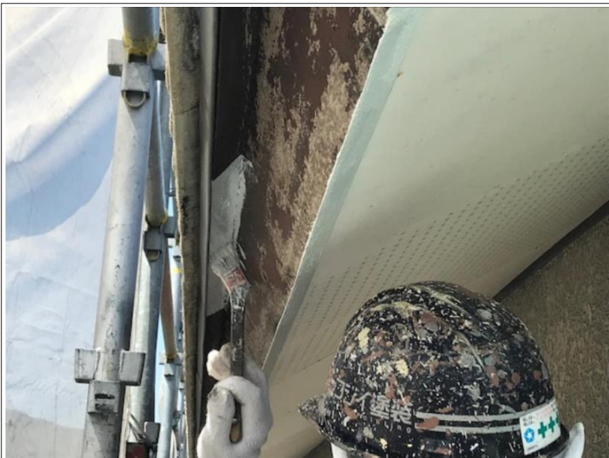
破風板 下塗り
