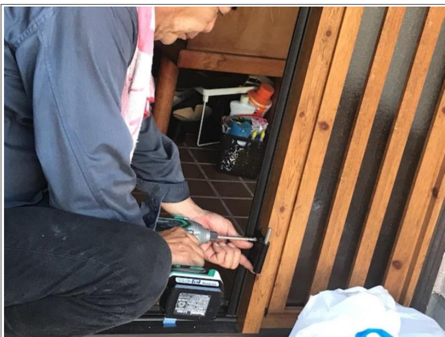
玄関ドア 取付け
