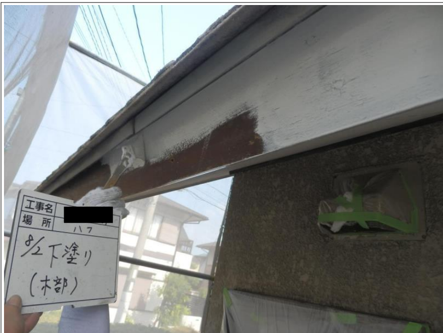
破風板 下塗り
