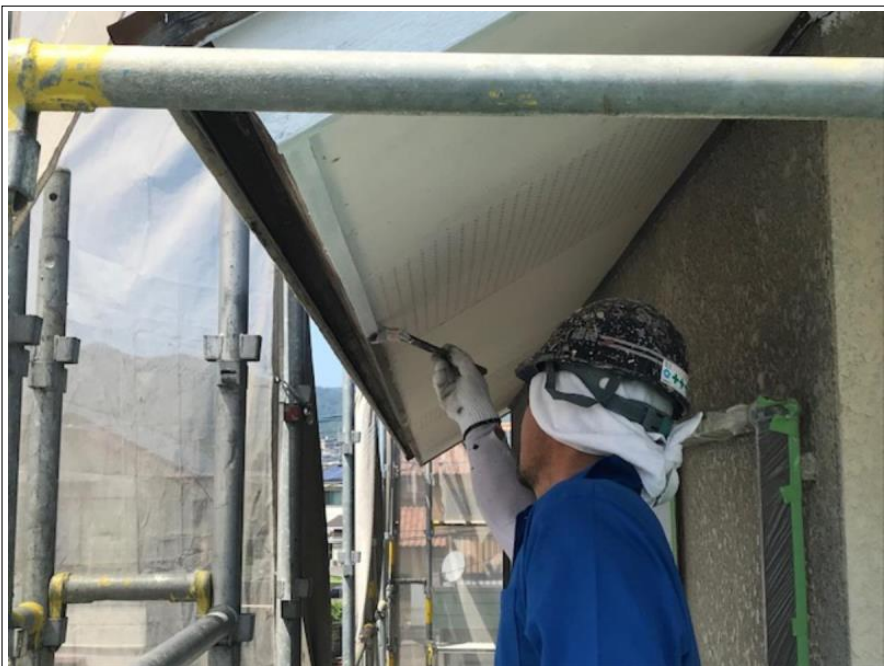
破風板 下塗り
