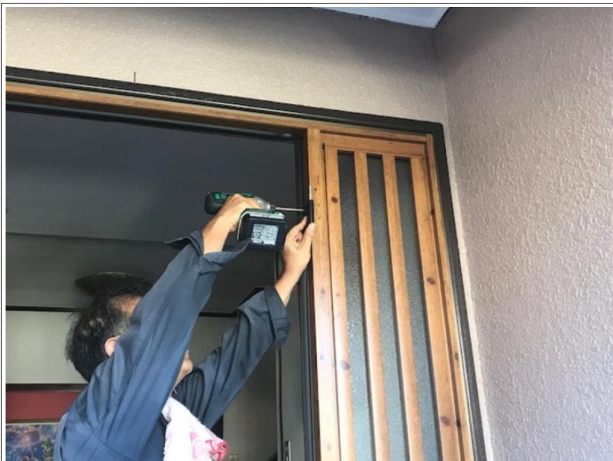
玄関ドア 取付け
