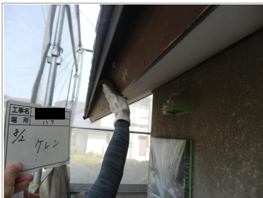
破風板 ケレン
