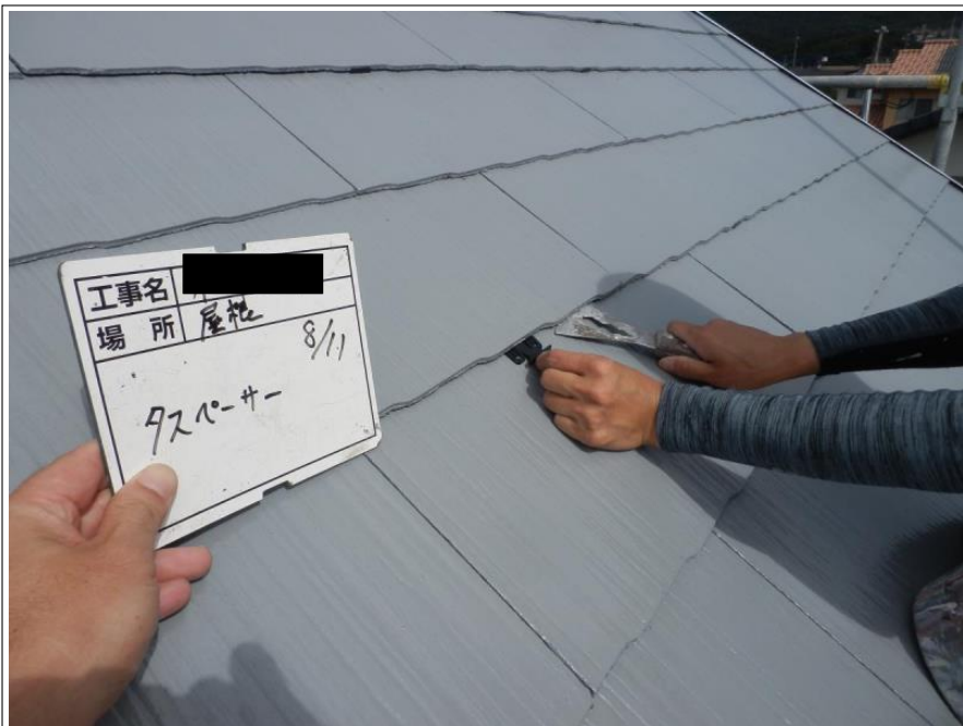
屋根 タスペーサー取付
