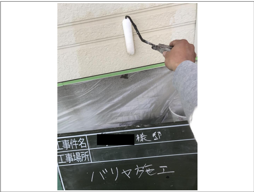
外壁 バリヤー塗布
