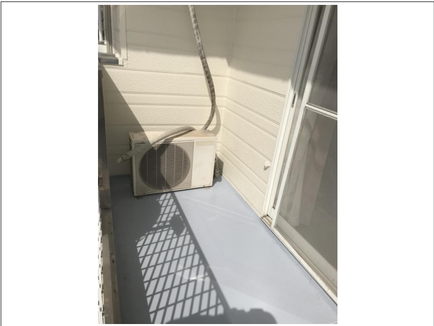
ベランダ床 施工完了
