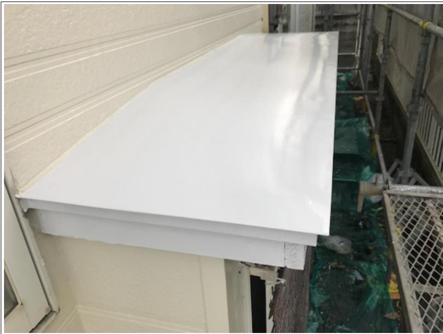
小庇 施工完了
