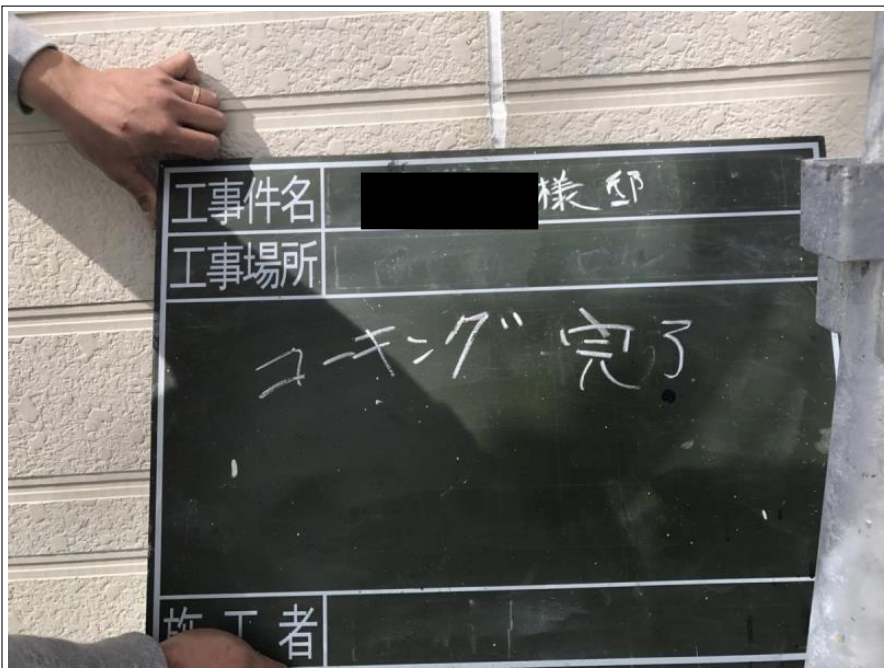
コーキング 施工完了
