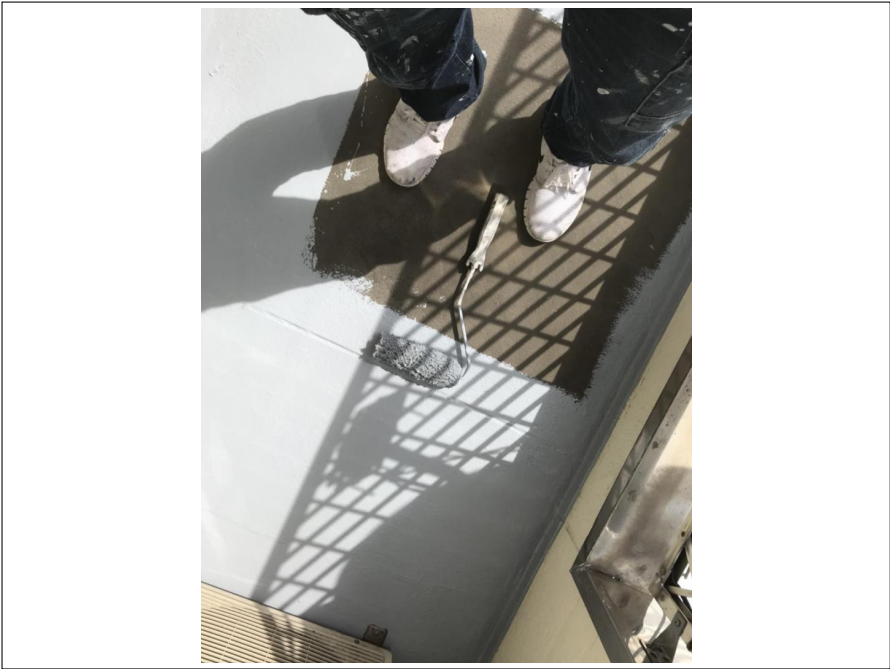
ベランダ床 上塗り施工中
