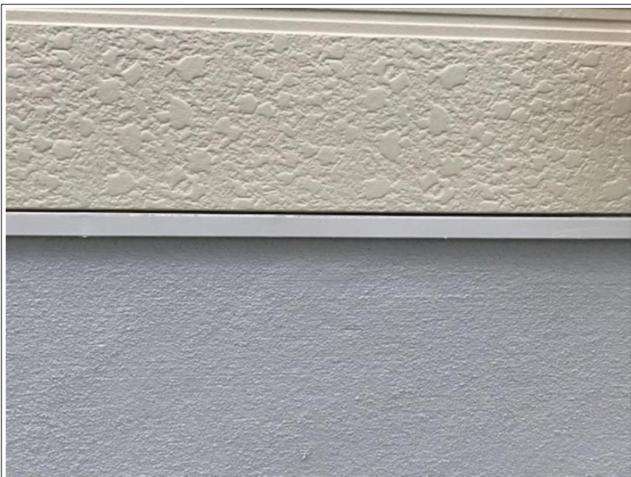
水切り 施工完了
