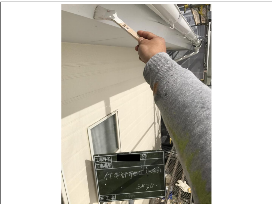
破風板 上塗り施工中
