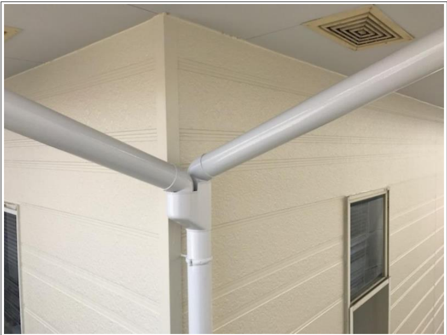
雨樋 上塗り施工後
