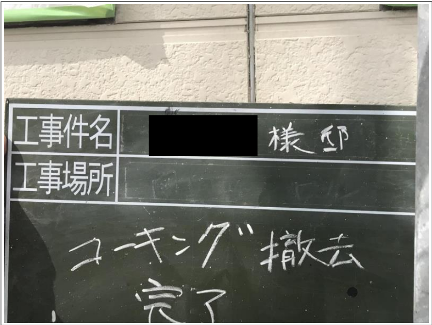
コーキング撤去 完了
