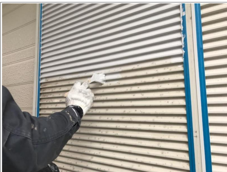
雨戸 上塗り施工中
