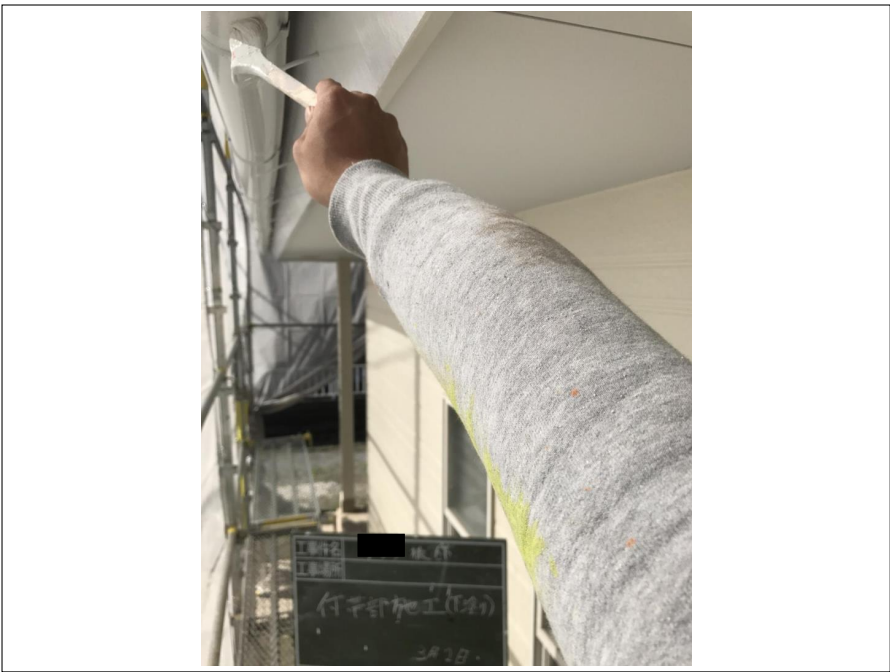
雨樋 上塗り施工中
