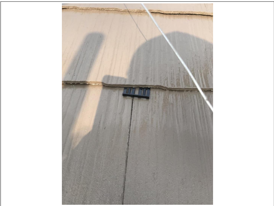
タスペーサー取付
