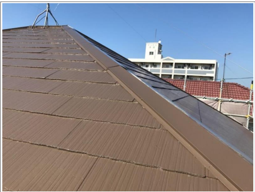
屋根 施工完了
