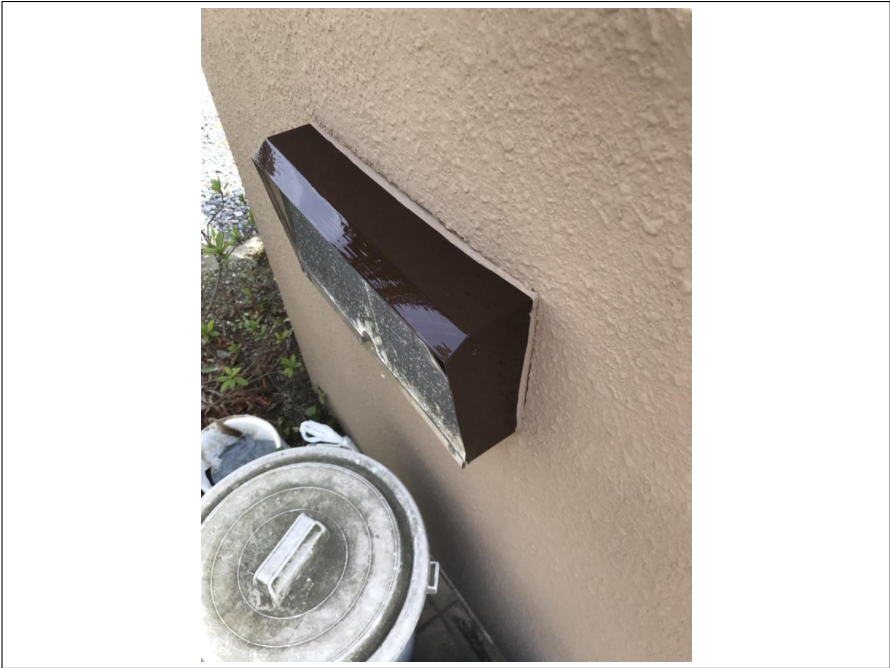
ポスト 上塗り施工後
