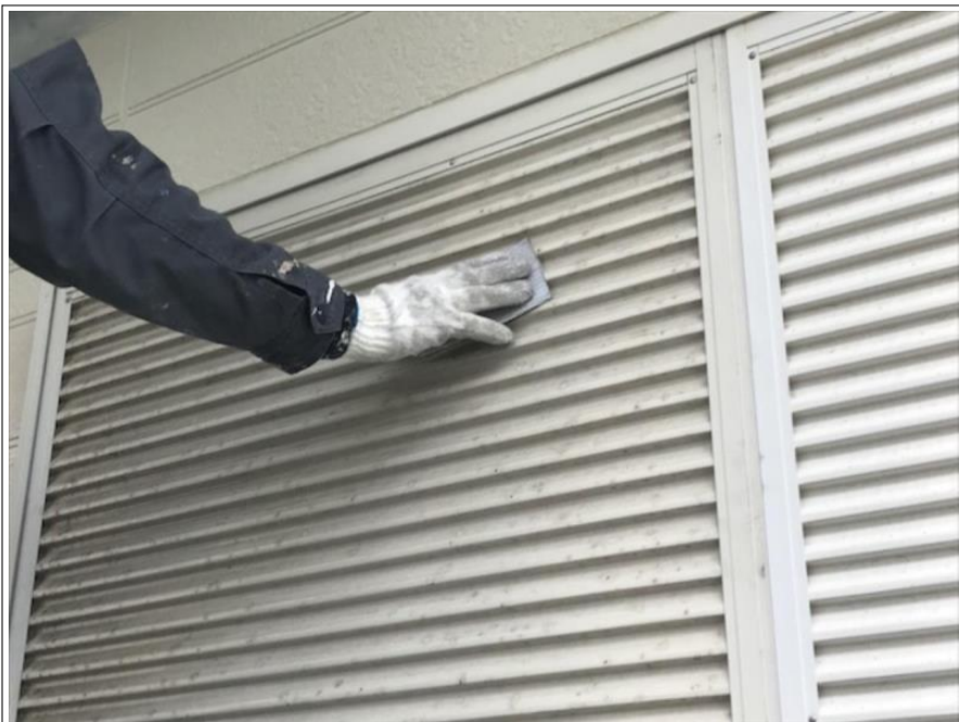
雨戸 ケレン作業
