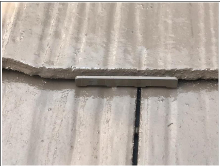
タスペーサー取付
