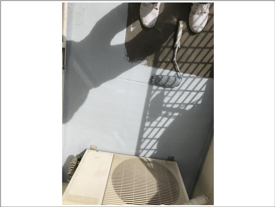
ベランダ床 上塗り施工中
