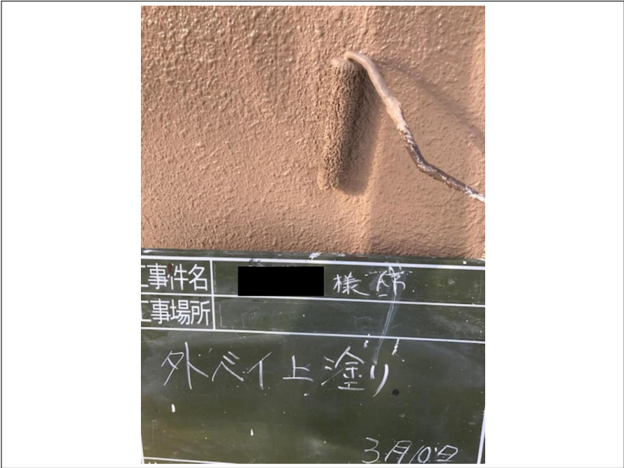
塀 上塗り施工中
