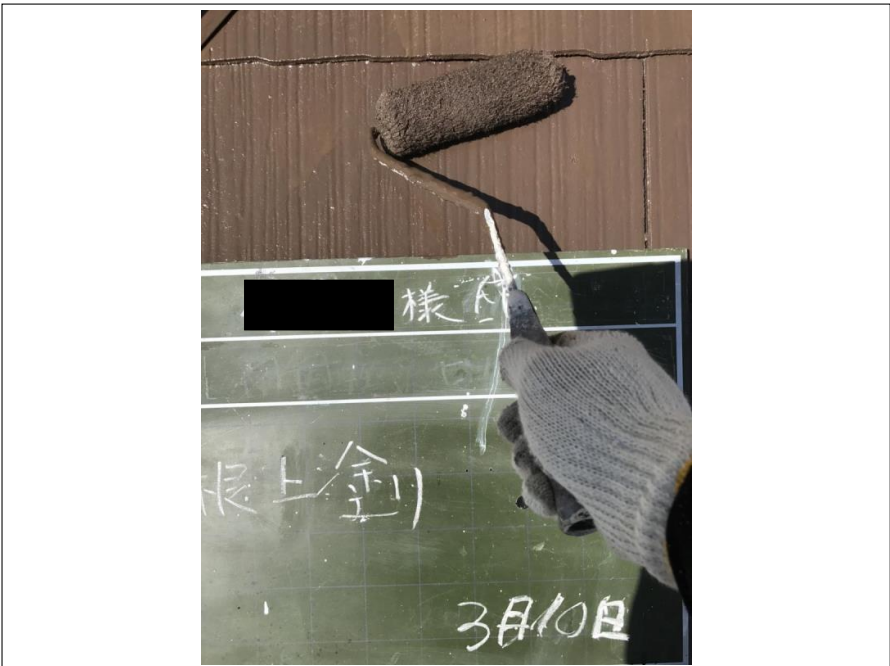
屋根 上塗り施工中
