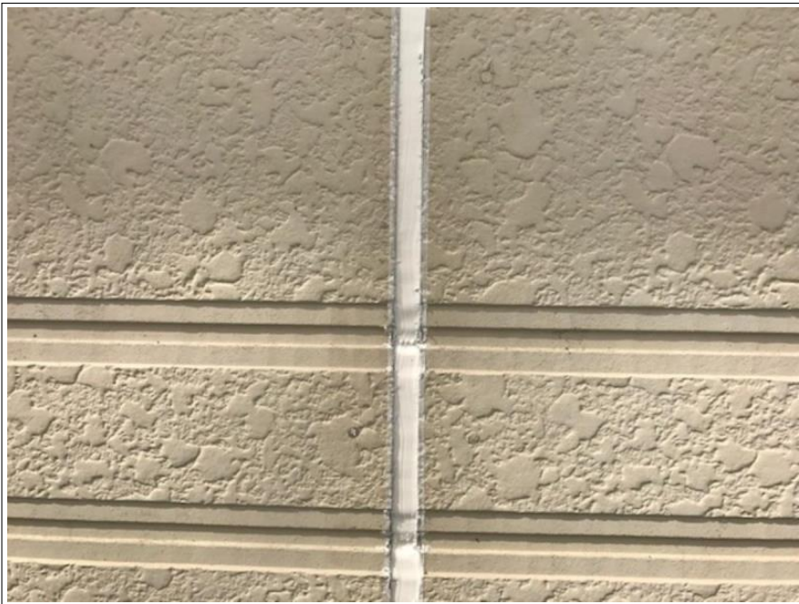
コーキング 施工完了
