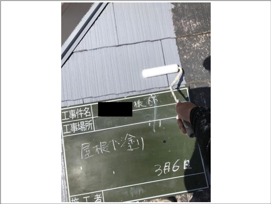
屋根 下塗り施工中
