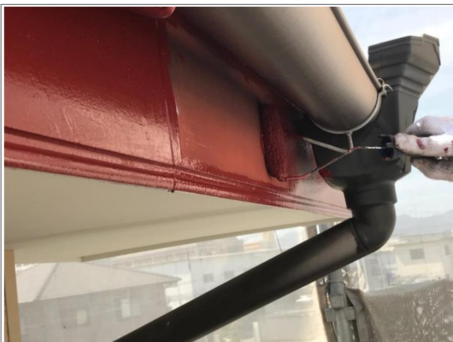
破風板 上塗り 2回目
