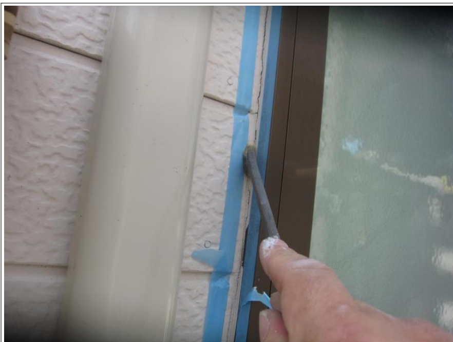
サッシ廻り シーリング補修
