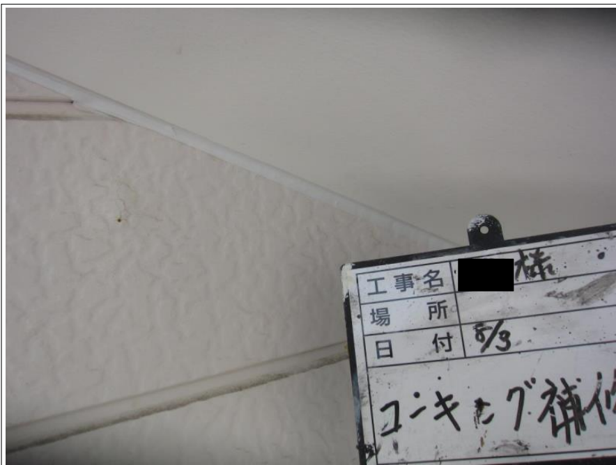
その他 シーリング補修
