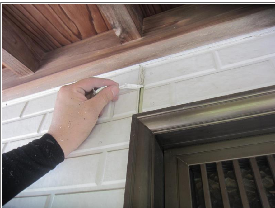
シーリング除去
