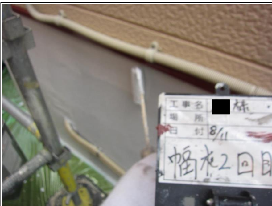
基礎 上塗り 2回目
