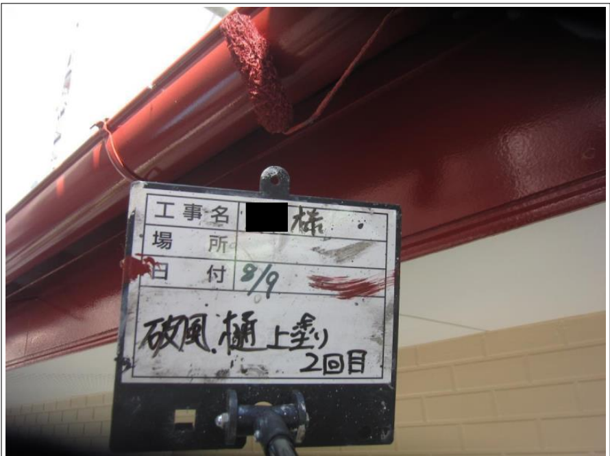
樋 上塗り 2回目
