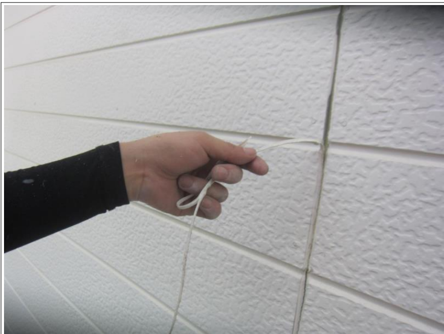
シーリング除去
