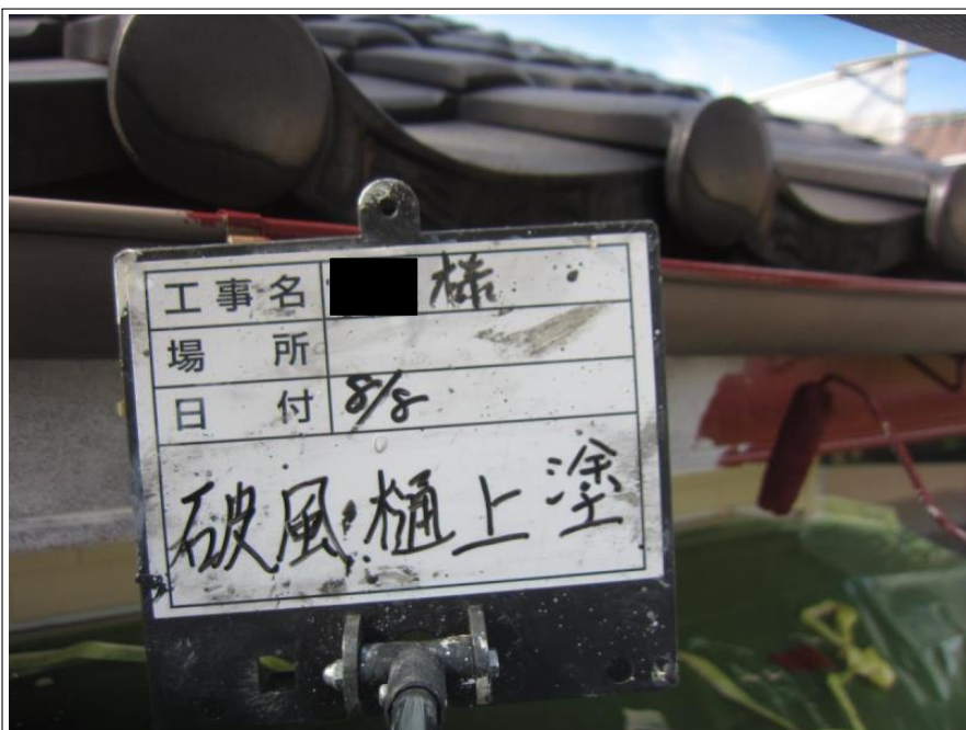
破風板 上塗り
