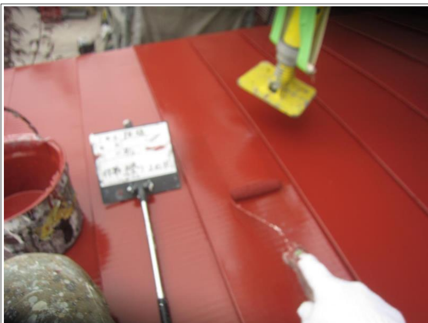
玄関屋根 上塗り 2回目
