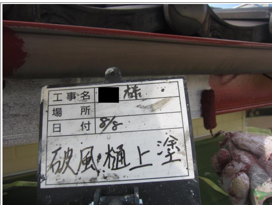
破風板 上塗り
