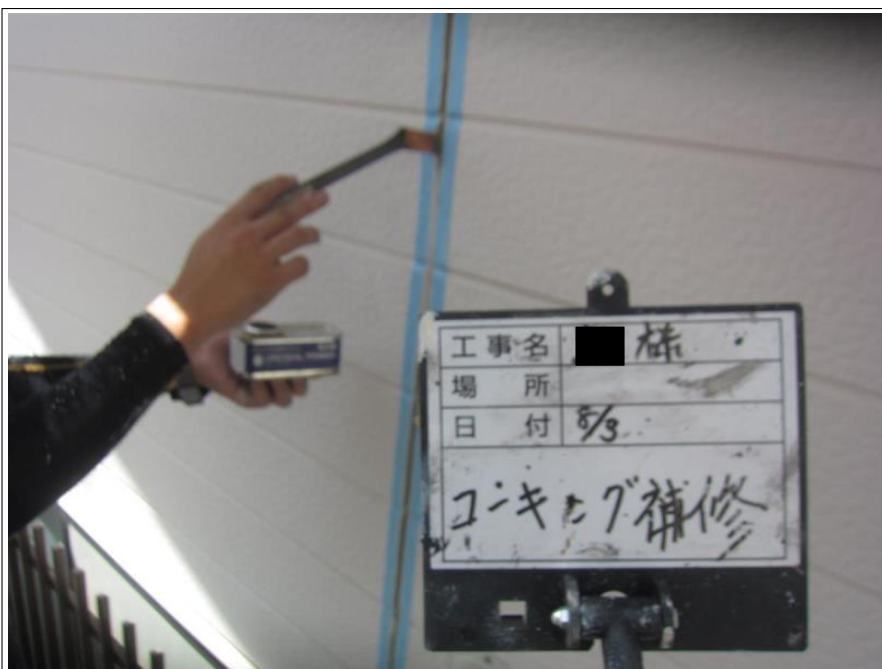
ボード シーリング補修
