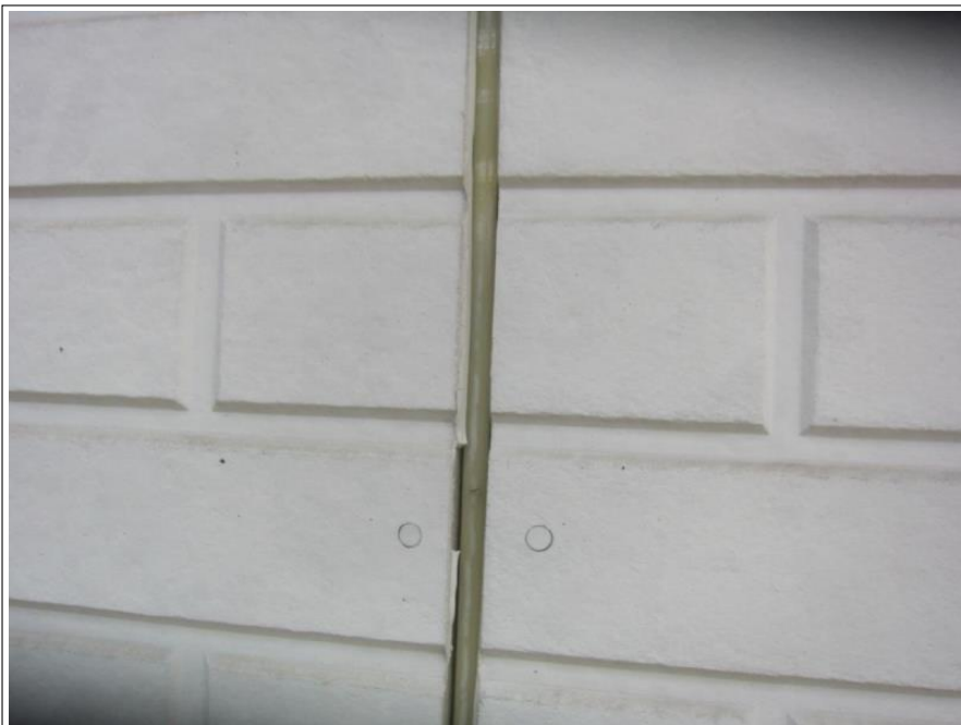
シーリング除去
