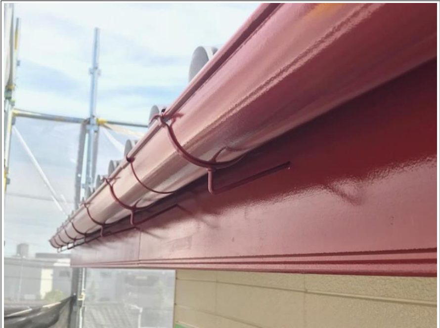
破風板・樋 完了
