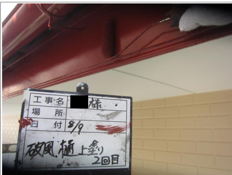
破風板 上塗り 2回目
