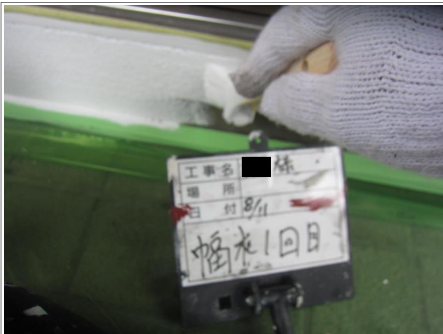
基礎 上塗り 1回目
