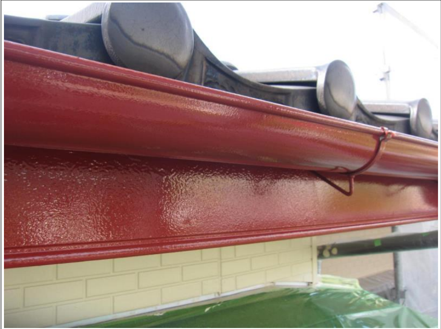
破風板・樋 完了
