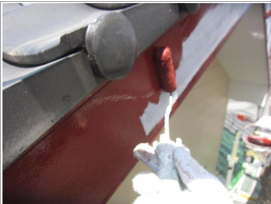
破風板 上塗り
