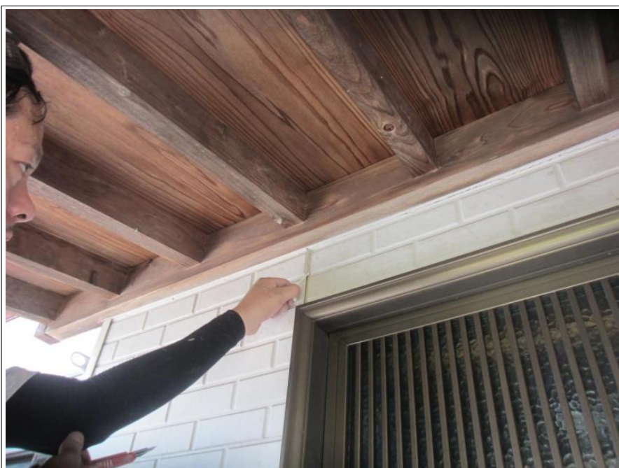
シーリング除去
