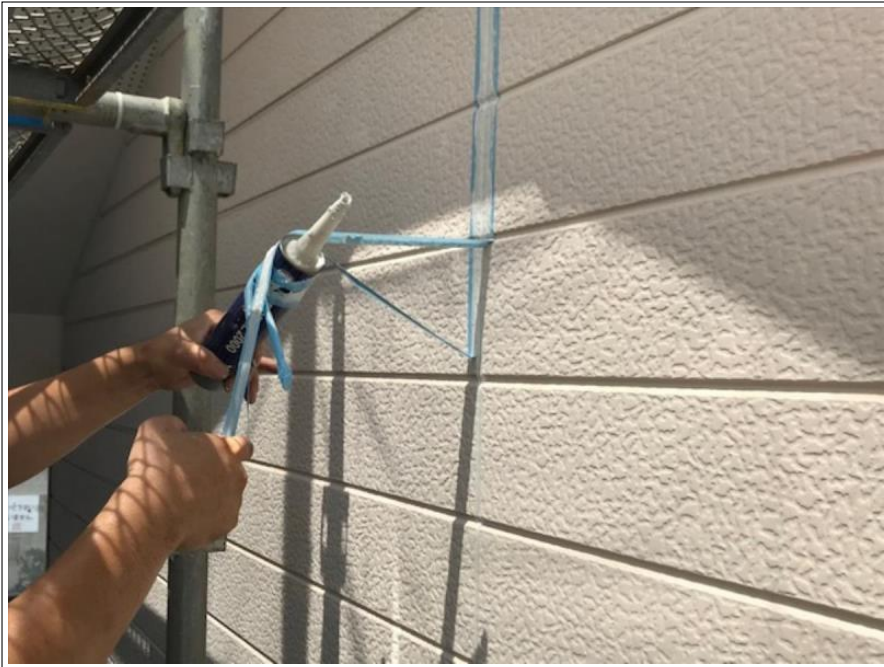
ボード シーリング補修
