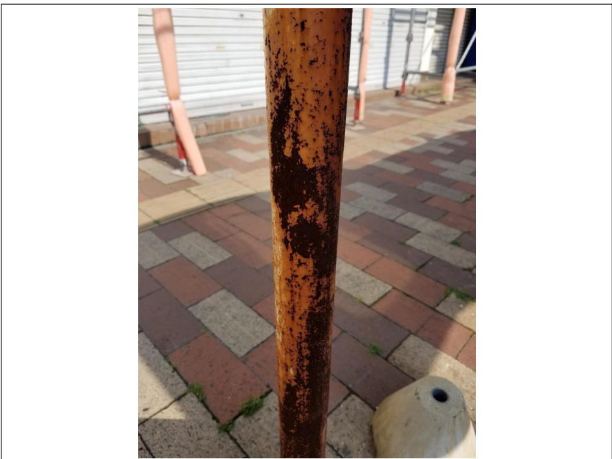
テント 鉄骨 着工前
