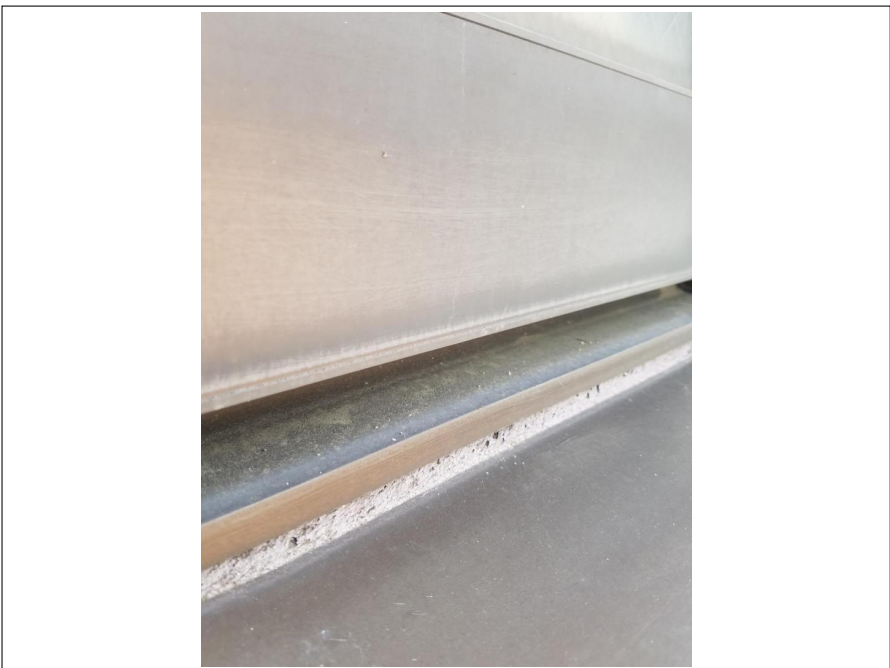
シーリング部 施工前
