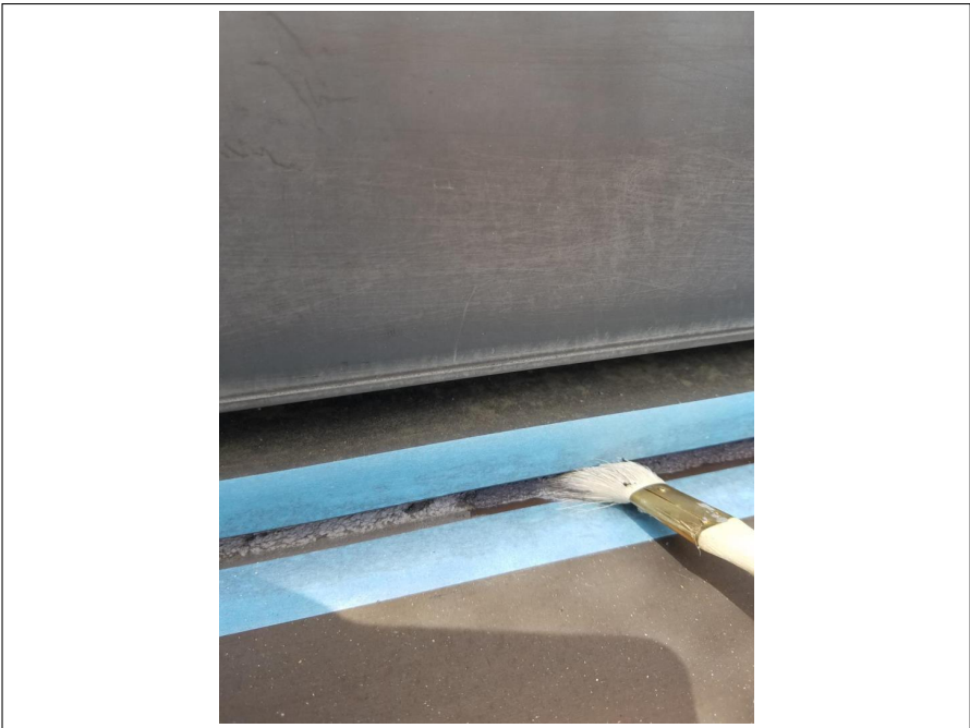
シーリング部 プライマー塗布
