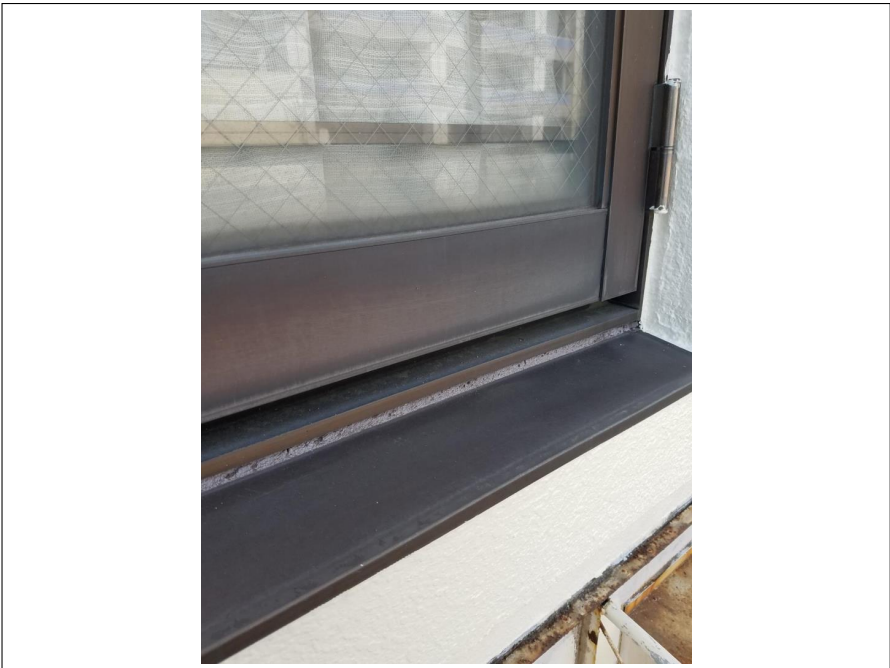
シーリング部 施工前
