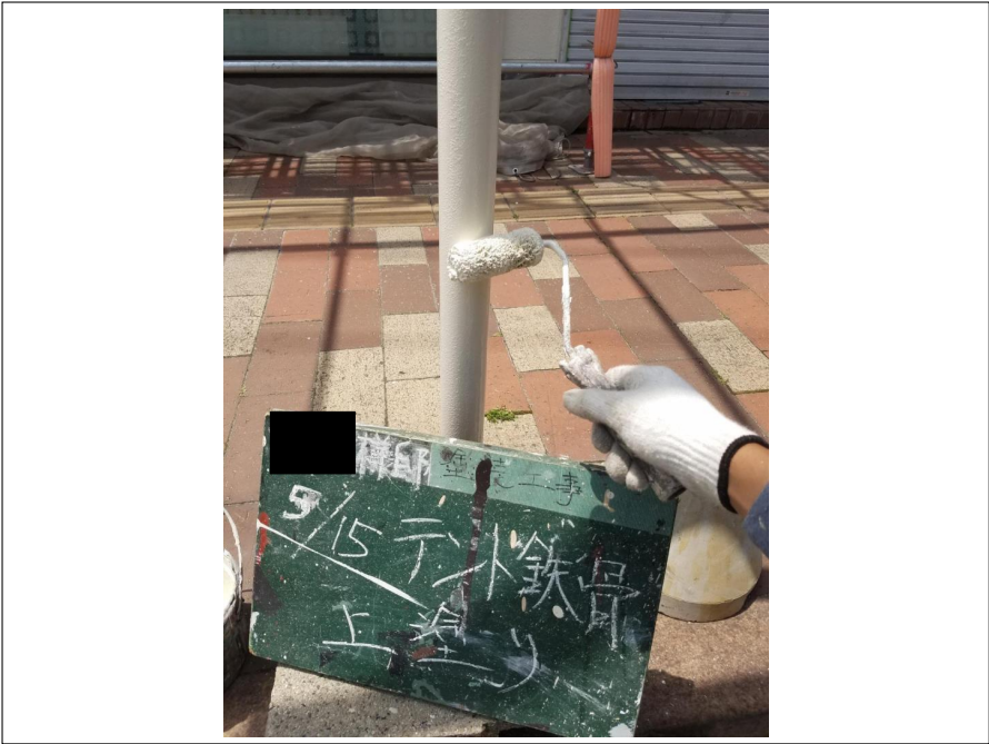
テント 鉄骨 上塗り
