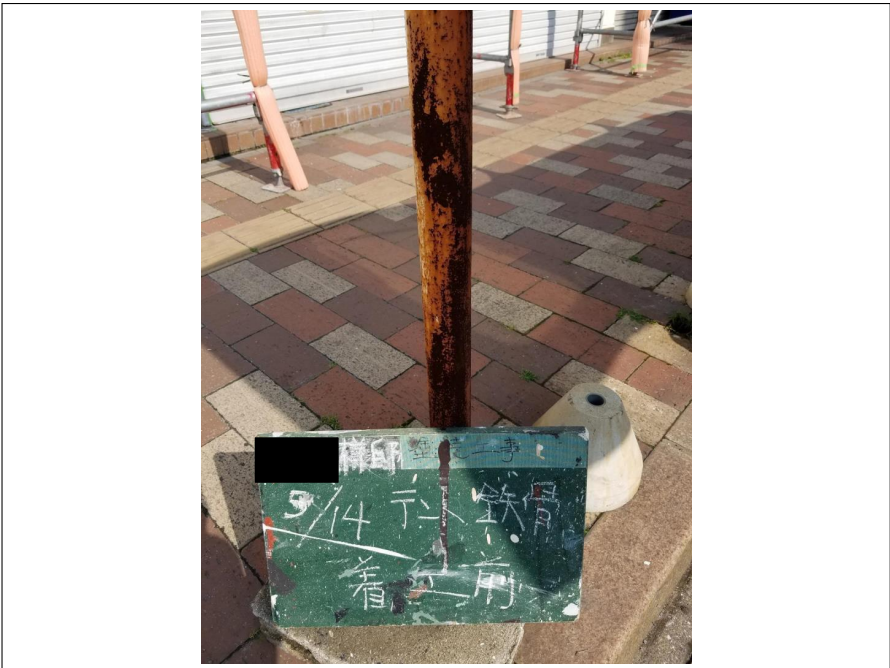
テント 鉄骨 着工前
