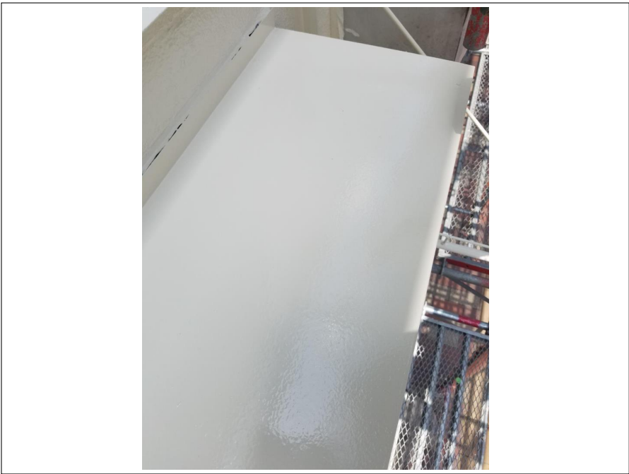
シャッターボックス 施工完了
