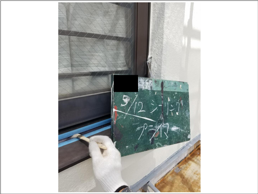
シーリング部 プライマー塗布
