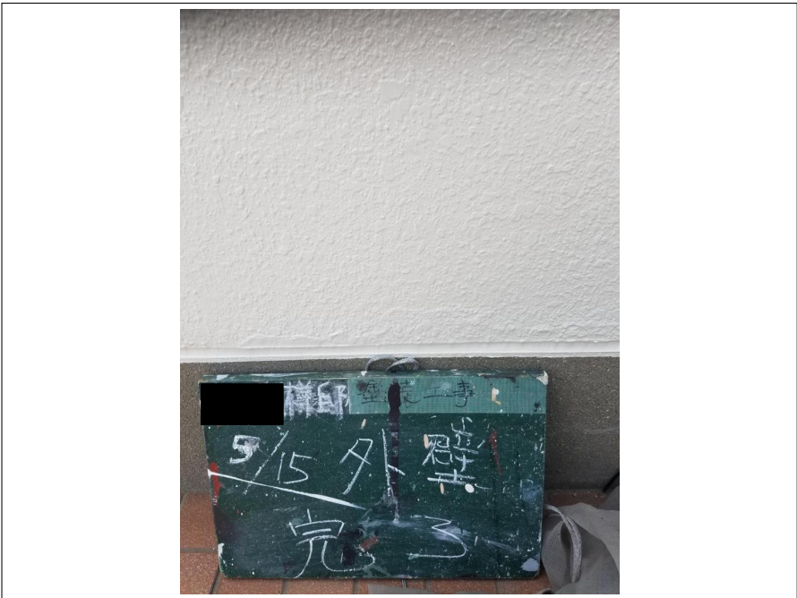
外壁 塗装完了
