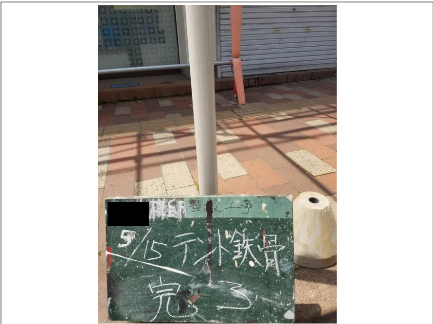
テント 鉄骨 完了
