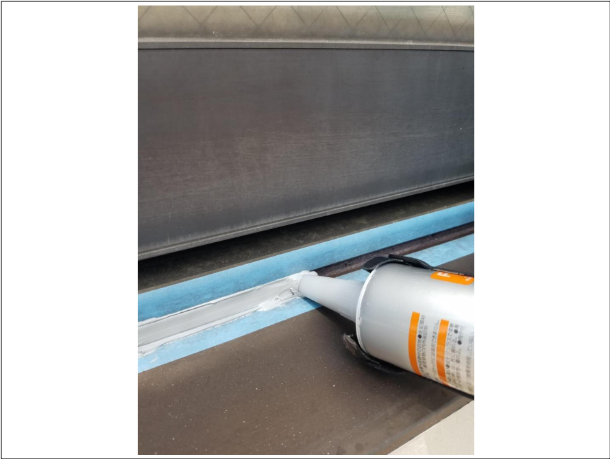
シーリング部 シール材打設
