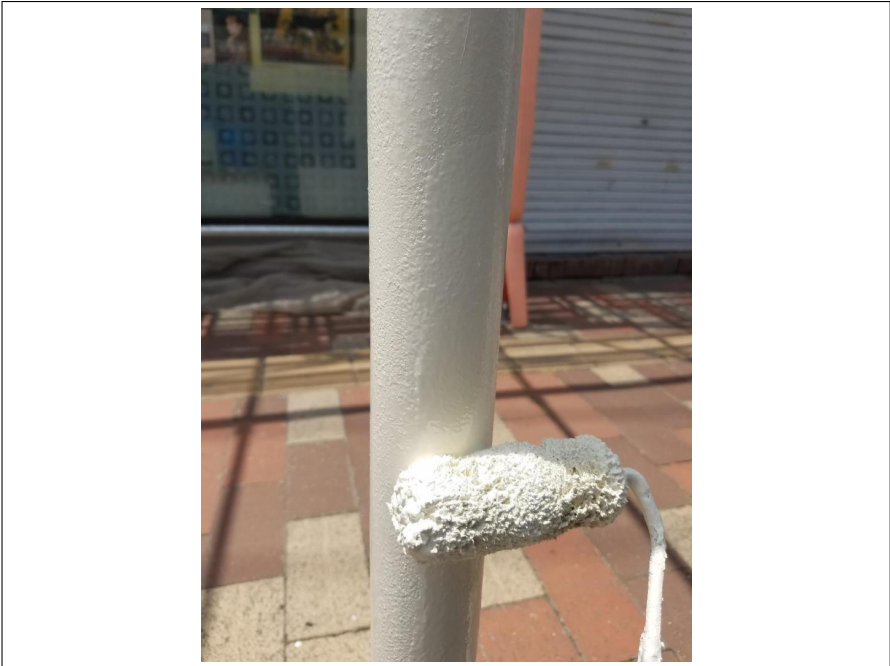
テント 鉄骨 上塗り
