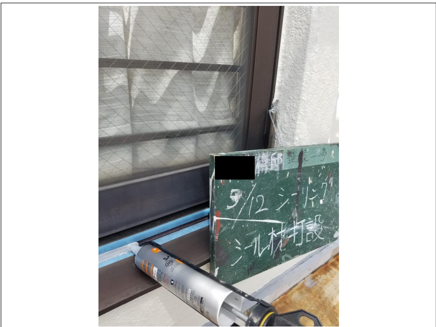
シーリング部 シール材打設
