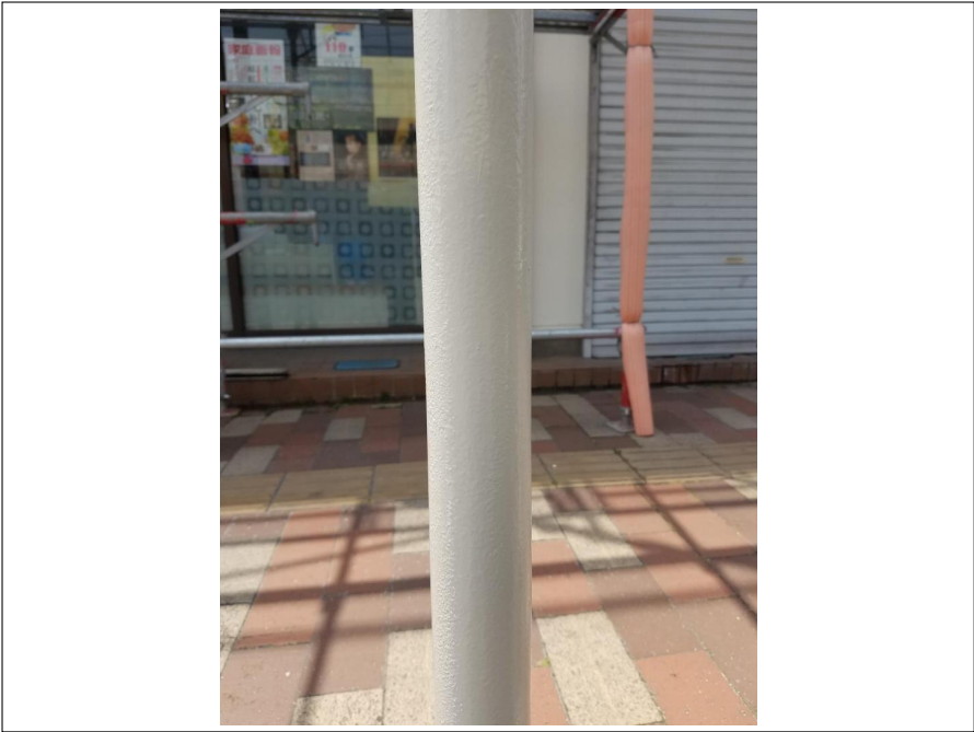
テント 鉄骨 完了
